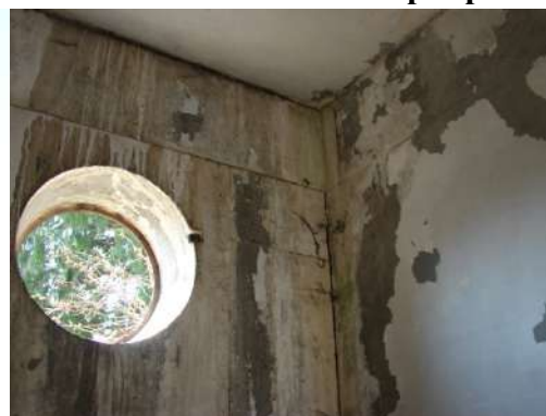
Intérieur de la chapelle délabré suite aux infiltrations et épitaphes devenues illisibles.
