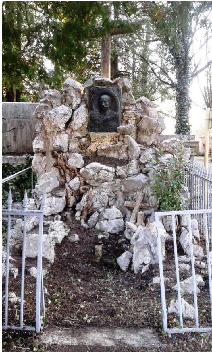
Après le débroussaillage par les bénévoles et avant l'intervention des entreprises
