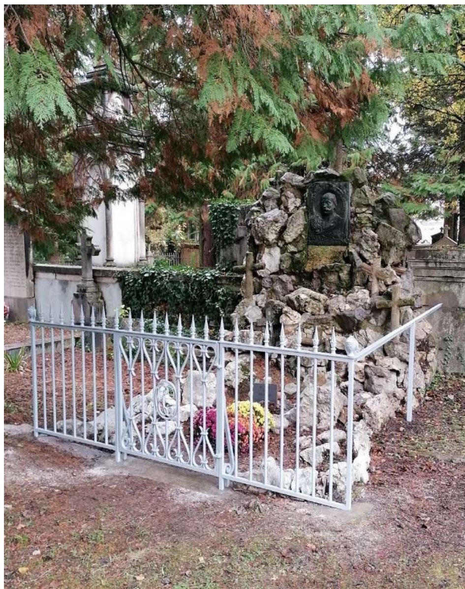
Novembre 2022 - Pose de la nouvelle grille réalisée par les Ets Guillot
