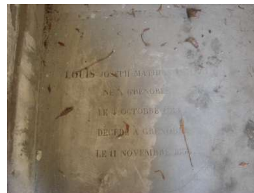
Intérieur de la chapelle délabré suite aux infiltrations et épitaphes devenues illisibles.
