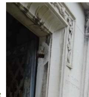
La charnière de la porte est en train de se desceller, un bloc de pierre s'est détaché en 2022.
