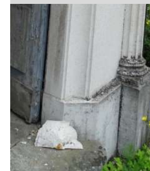
La charnière de la porte est en train de se desceller, un bloc de pierre s'est détaché en 2022.
